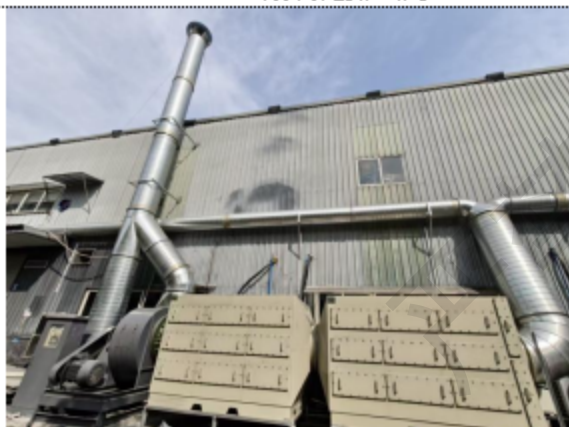
DA004（胶料车间排气筒）
